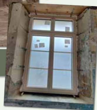
Pose de menuiseries à l'ancienne école Place de l'Abbaye
