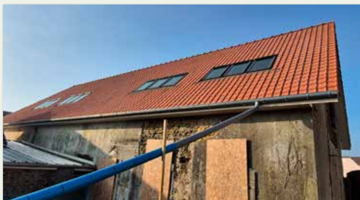
◀ Pose de velux
