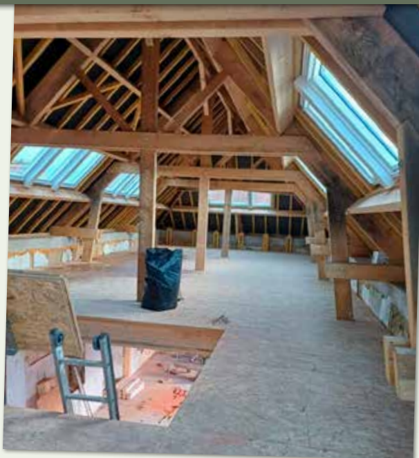
Pose d'une nouvelle charpente
