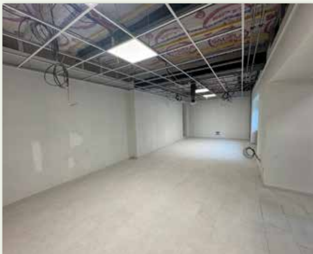
Avancement des travaux de transformation du pôle accueil de la mairie
