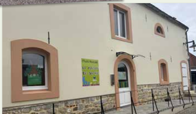
Remise en peinture de la Maison de Jackie par la CCDS
