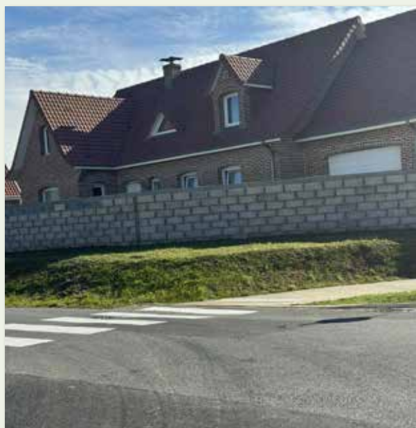
Réparation de la voirie, rue de Longuerèques, suite à un affaissement
