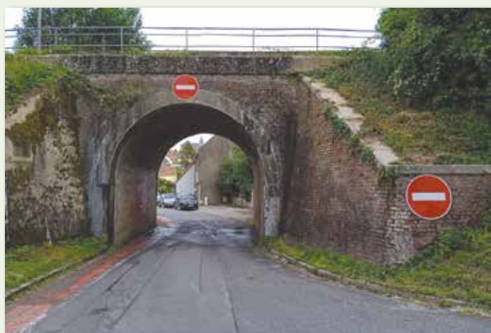
Pose des panneaux de signalisation pour acter la mise en sens unique de la rue du Breuil
