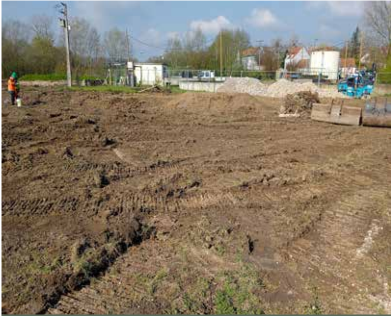
Début des travaux de la station d'épuration - 5 800 000 €
