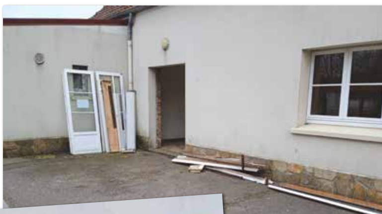
Changement des fenêtres à la salle de restauration
