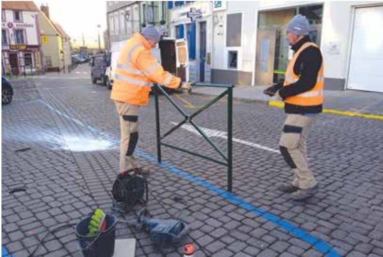
Installation de barrières pour la sécurité des piétons
