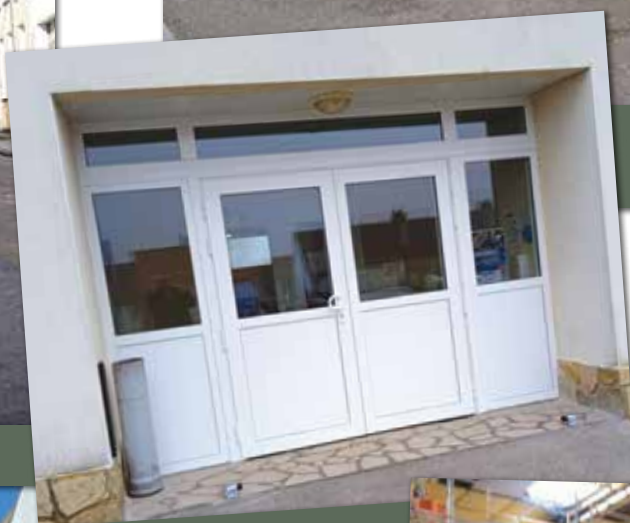
Changement des portes à la salle de restauration
