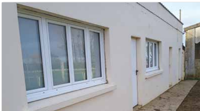
Changement de fenêtres des vestiaires du Stade Ansart
