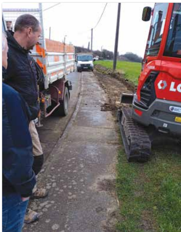
Aménagement de places de stationnement rue de Neufchâtel
